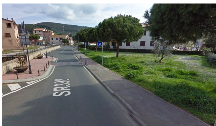
Figura 321 Esempio di attraversamento pedonale protetto da una strettoia con istituzione del senso unico alternato
