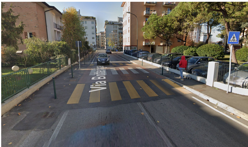
Figura 310 Esempio di attraversamento pedonale rialzato
