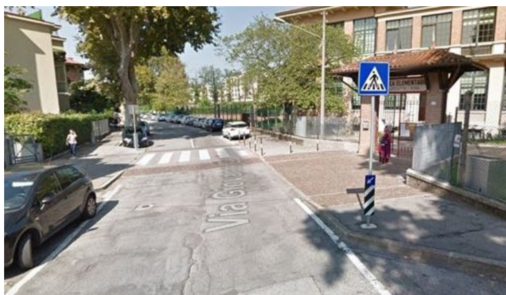
Figura 320 Esempio di restringimento della piattaforma a spese della sosta con avanzamento del marciapiede in corrispondenza di un attraversamento pedonale e piattaforma rialzata
