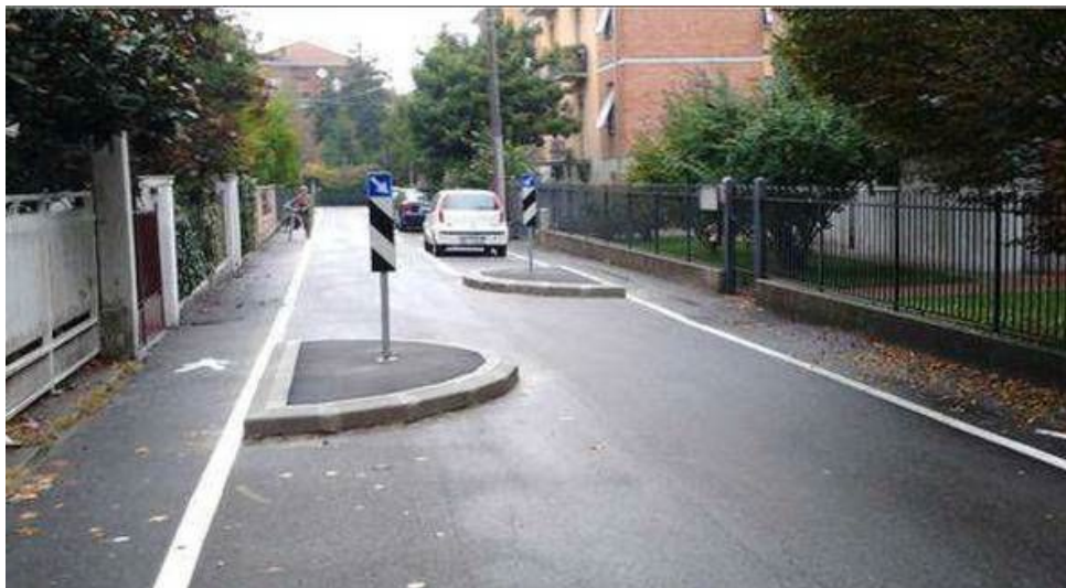
Figura 313 Esempio di chicane realizzata con alternanza della sosta protetta da elementi sopraelevati
