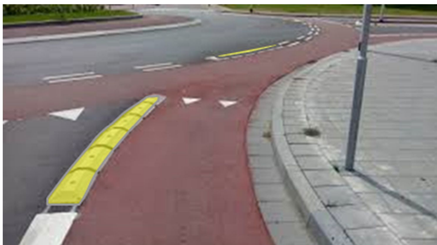
Figura 301 Protezioni dei percorsi ciclabili "banane vèlo"
