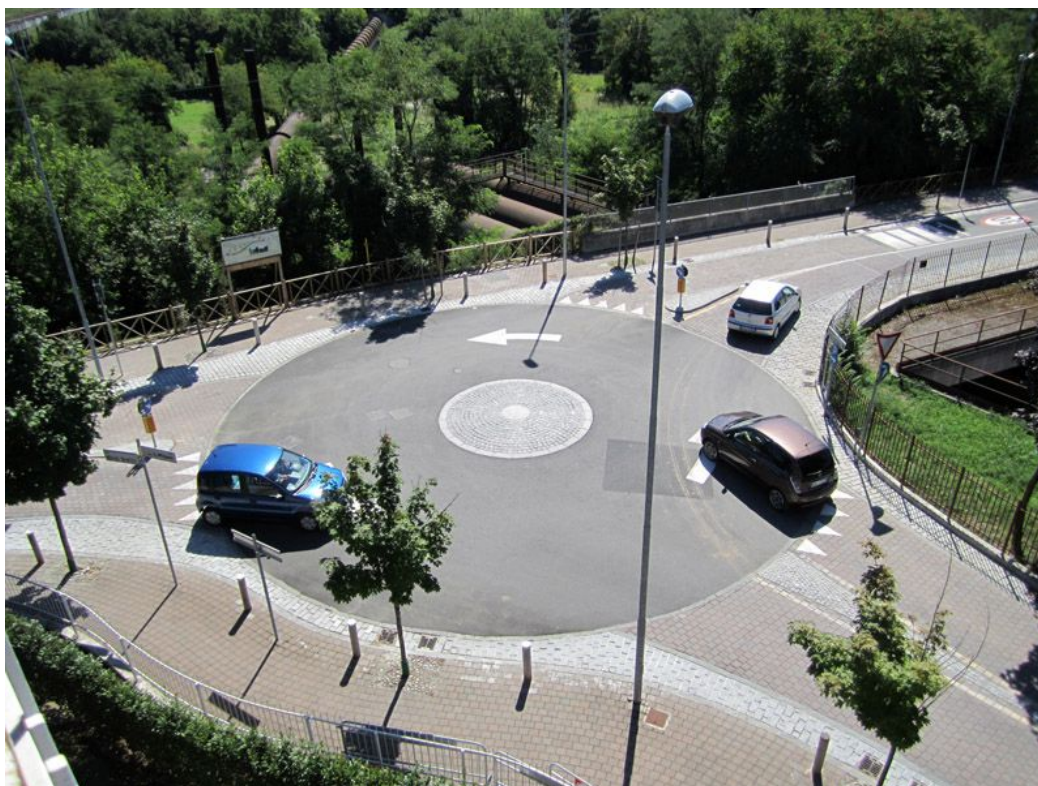
Figura 323 Esempio di rotatoria completamente sormontabile. In questo caso la rotatoria ha interrotto un rettilineo e costituisce un intervento di moderazione del traffico
