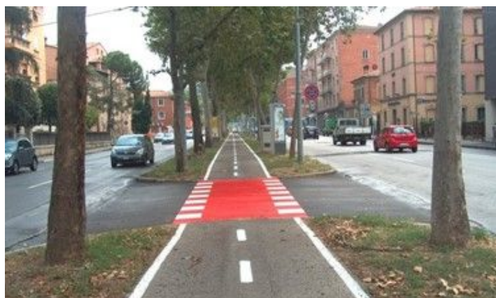
Figura 330 Esempio di pista ciclabile in sede propria bidirezionale separata da aiuole verdi
