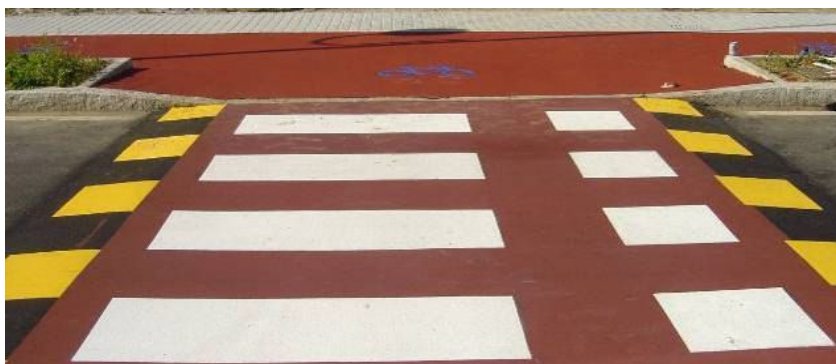
Figura 347 Esempio di attraversamento ciclopedonale con leggera sopraelevazione
