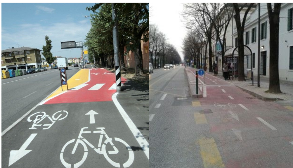
Figura 307 Esempi di interferenza tra fermata bus e percorso ciclabile
